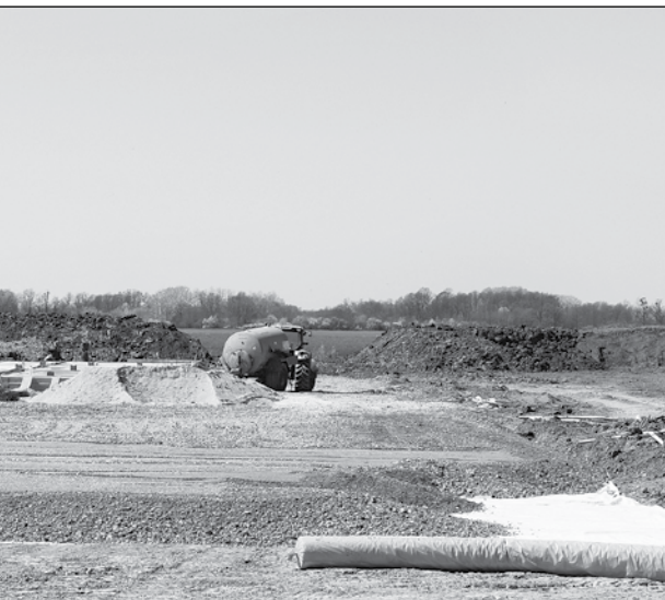
Okolo postrojenja se gradi i zaštitni nasip
