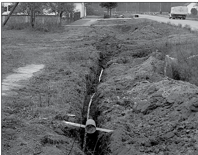
Radovi na izgradnji vodovodne mreže u Savskoj ulici
