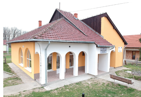
Stanje nakon obnove
