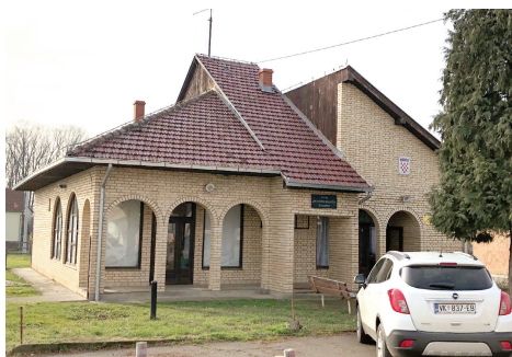
Stanje prije obnove
