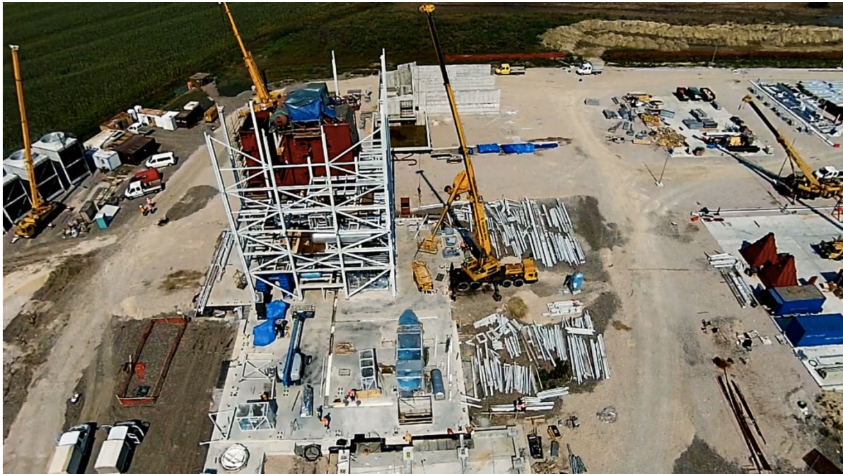
Slika 7.1 Gradilište kogeneracijskog postrojenja na biomasu u gospodarskoj zoni Tečine
